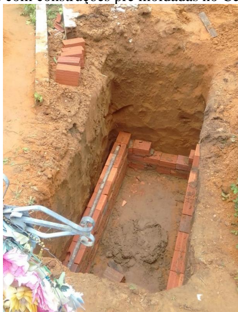
Figura 27: Jazigos com construções pré moldadas no Cemitério de Ritópolis
