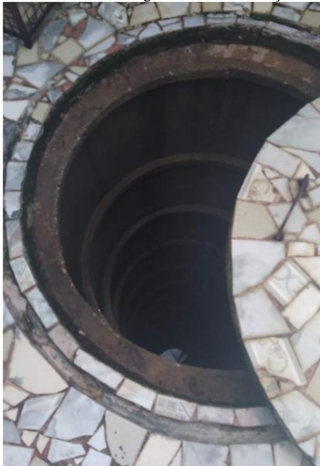
Figura 10: Ponto de coleta da água subterrânea -Poço do tipo cisterna
