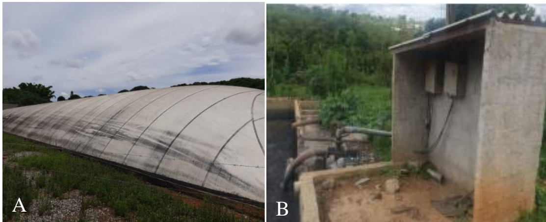
Figura 5. 2: Biodigestor (A) e casa de energia do tanque de alvenaria (B).
