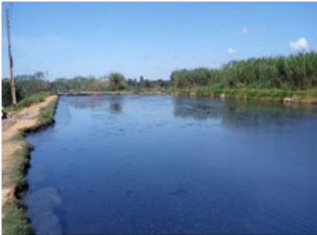
Figura 5.3: Lagoa da segunda fase de tratamento.
