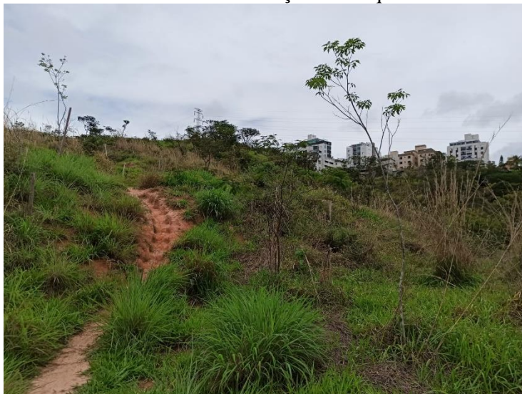
Figura 4.7 – Trecho com necessidade de intervenção no Parque Renato Azeredo Neto.
