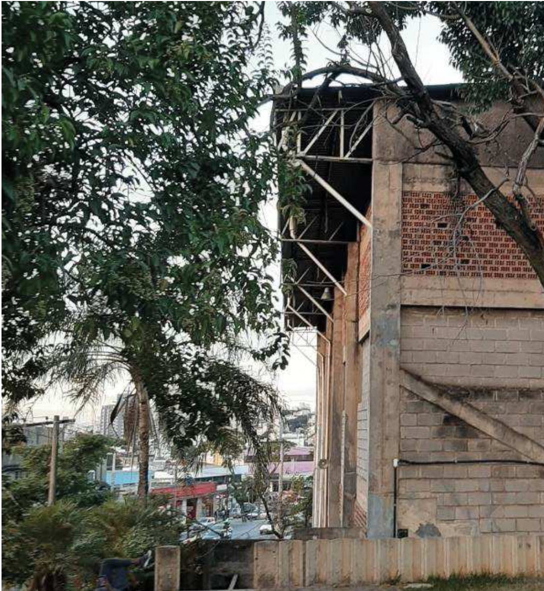
Figura 16 - Sistema de drenagem atual do ginásio.
