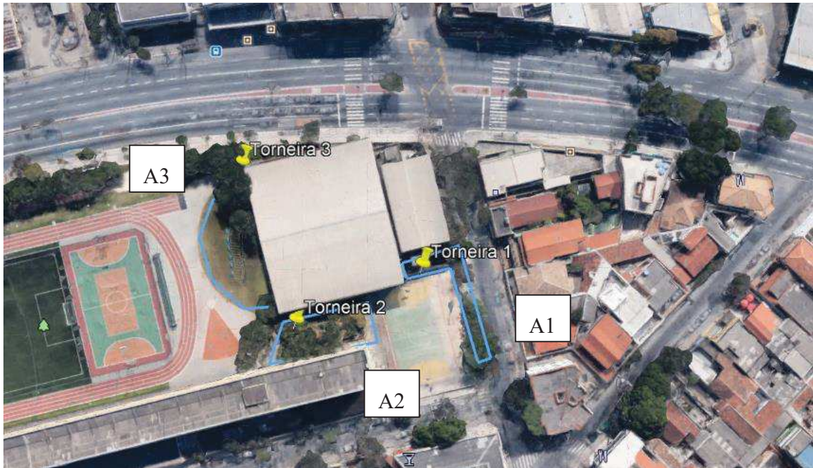
Figura 24 - Locais de instalação de torneiras
