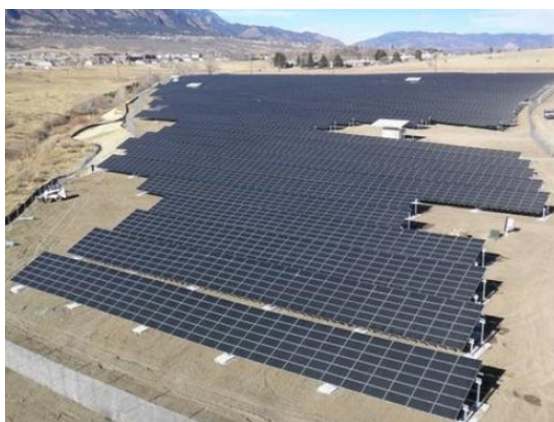
Figura 11 - Sistema fotovoltaico de inclinação fixa no aterro em Fort Cason, Colorado.
