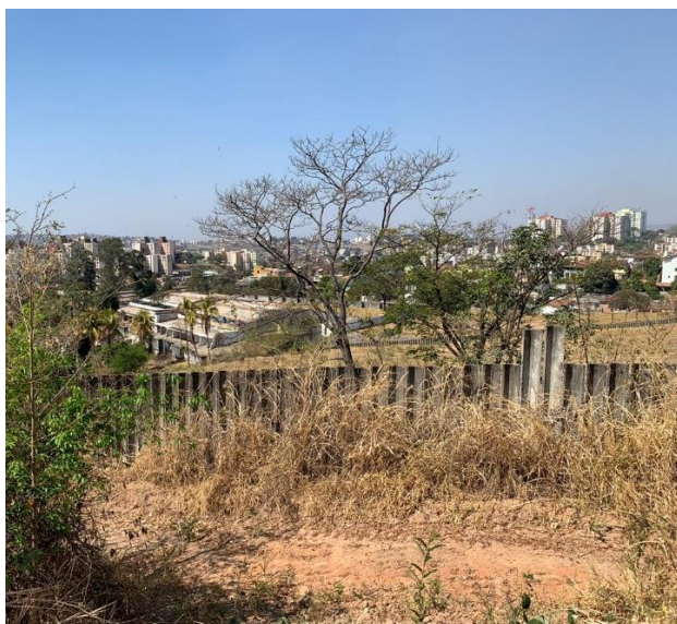
Figura 16 - Isolamento por muro de placas da CTRS BR040
