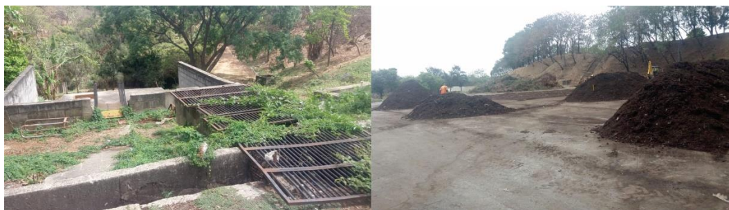
Figura 26 - Caixa coletora de percolado e pátio de compostagem
