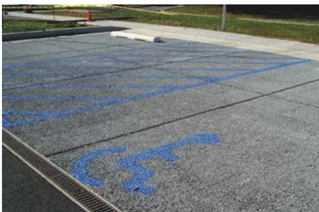
Figura 5 – Exemplo de pavimento permeável.
