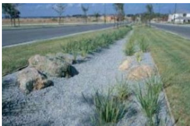
Figura 6 - Exemplo de trincheira de infiltração.
