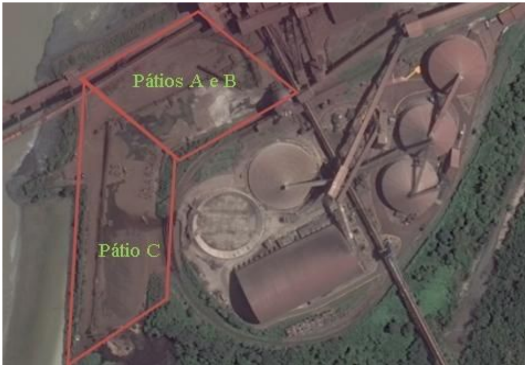
Figura 2: Pátios A B e C de estocagem de gusa e manganês
