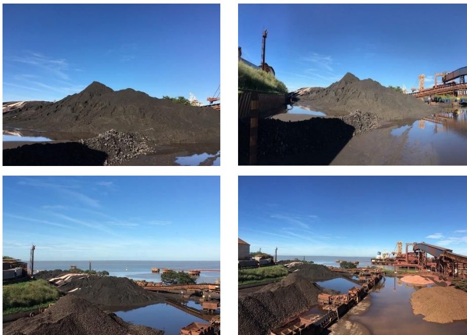
Figura 3: Pátio de armazenamento de gusa e manganês com geração de efluente
