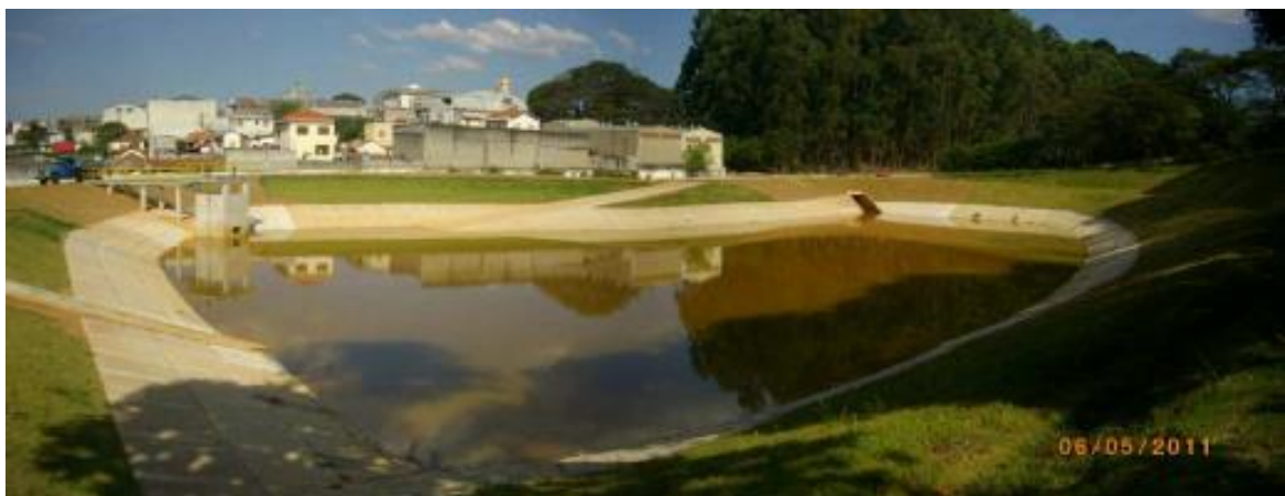
Figura 6 - Bacia de retenção no cemitério da Vila Formosa, em São Paulo.
