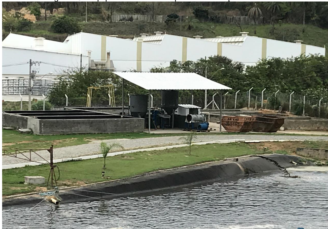
Figura 18 - Equipamento Decanter para desidratação de lodo.
