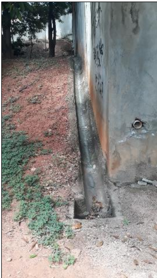
Figura 21 Meia cana localizada no muro de divisa entre o parque e as residências vizinhas.
