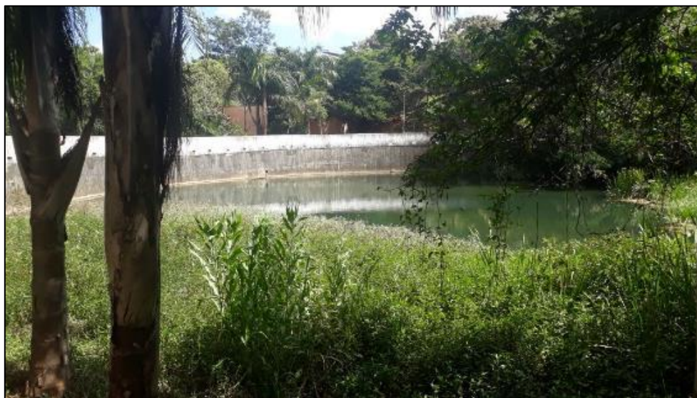
Figura 36 Vista da barragem pela margem esquerda da bacia de retenção.
