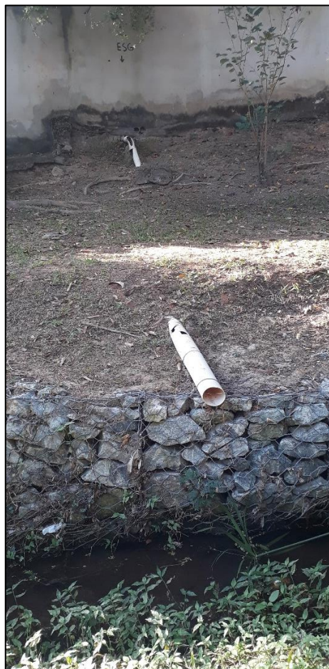
Figura 44 Tubulação indicada como de esgoto adentrando ao parque e sendo direcionada para o córrego.
