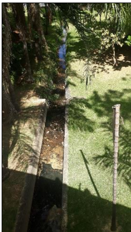
Figura 38 Córrego Primeiro de Maio à jusante da bacia de detenção.
