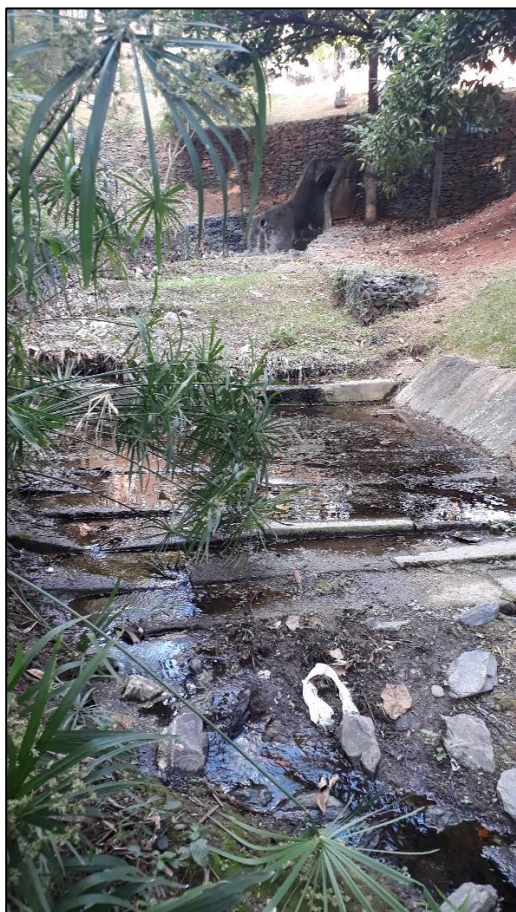
Figura 14 Vista dos degraus e da contenção das margens do canal aberto.
