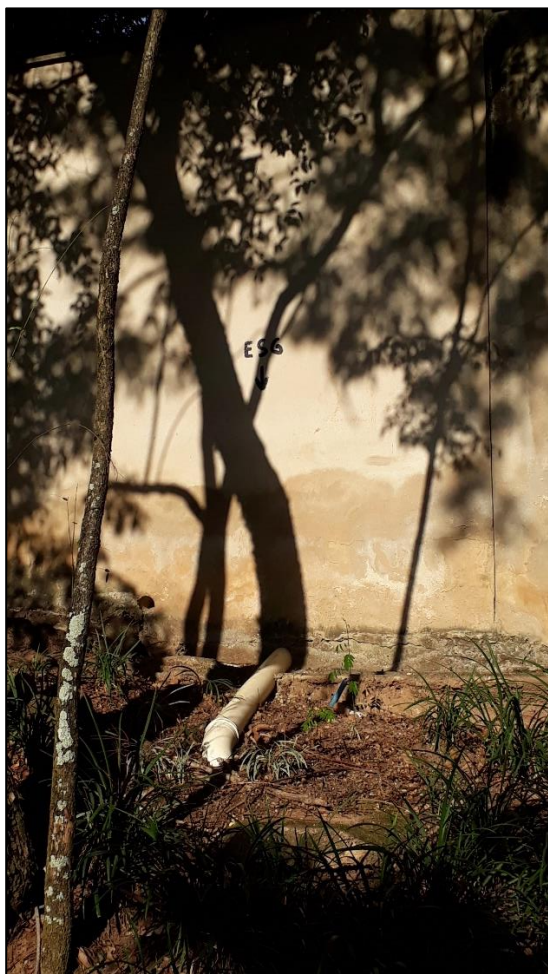
Figura 43 Tubulação indicada como de esgoto adentrando ao parque.
