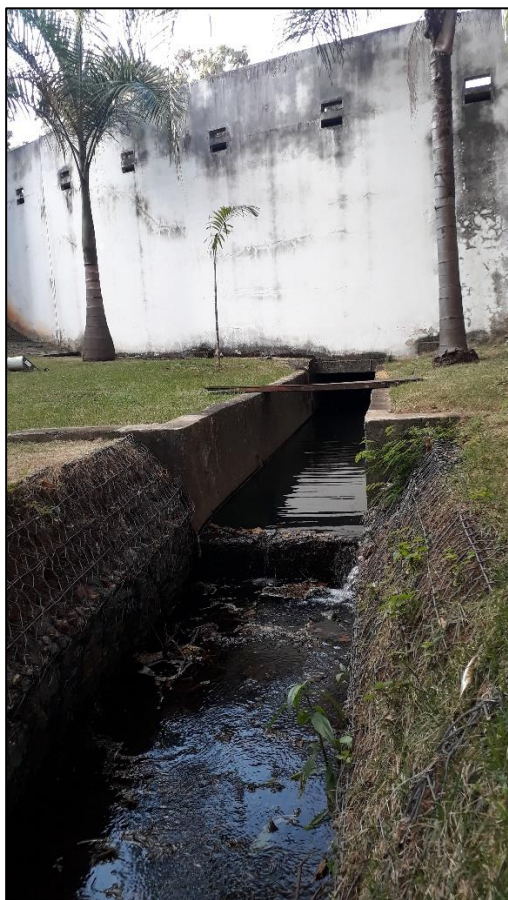
Figura 41 Córrego Primeiro de Maio à jusante da bacia de detenção no dia 15 de junho de 2018.
