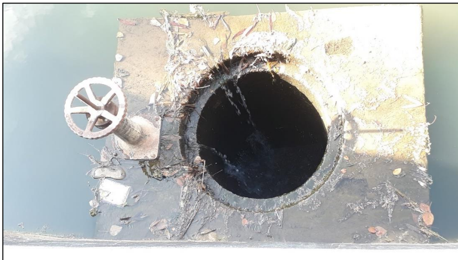
Figura 37 Comporta de entrada d'água na barragem.
