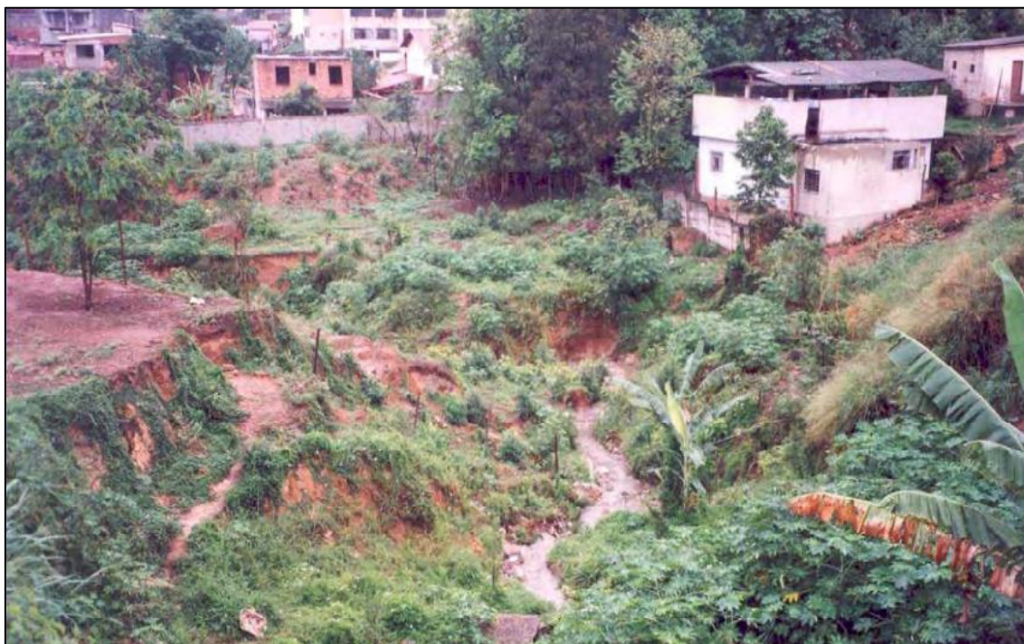
Figura 45 Situação antes do início das obras do programa Drenurbs.
