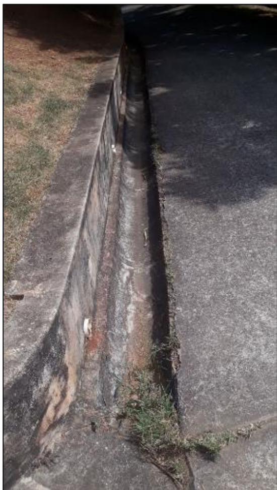
Figura 17 Meia cana encontrada próximo à portaria da rua Maria Ortiz.
