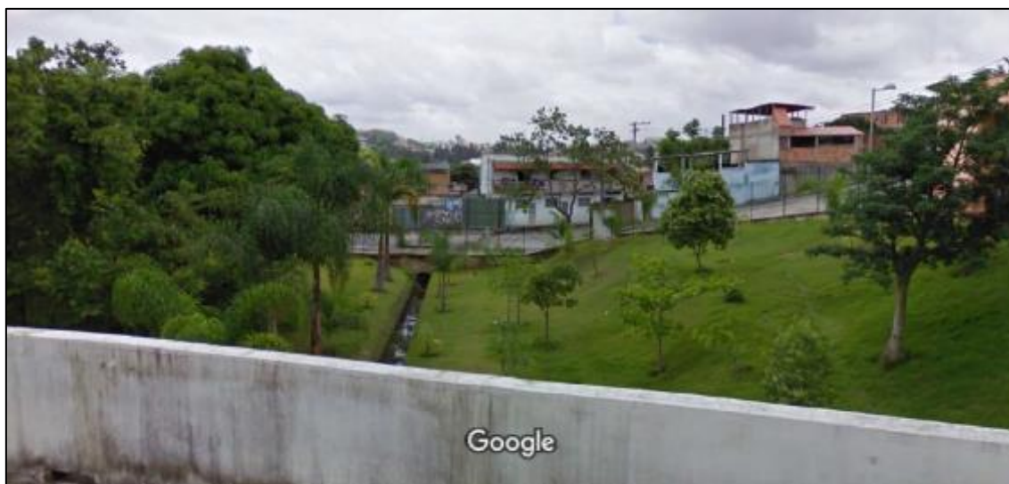
Figura 40 Vista do córrego Primeiro de Maio à jusante da barragem com a rua Penélope ao fundo.
