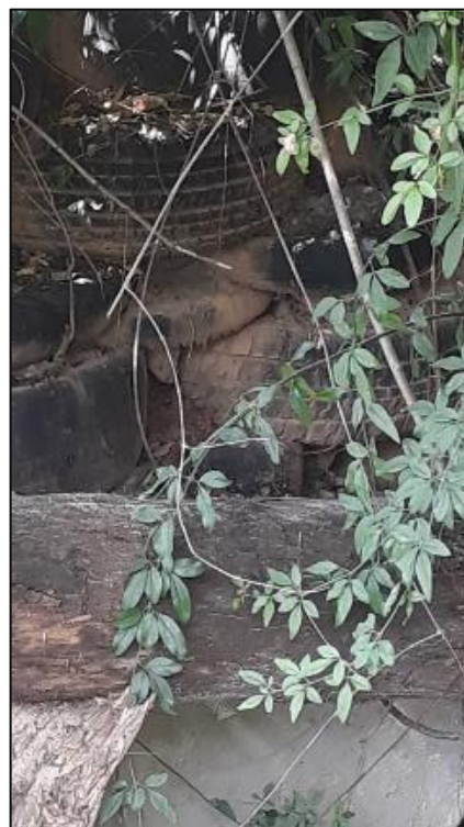
Figura 33 Detalhe do enrocamento com pneus verificado na Figura 32.
