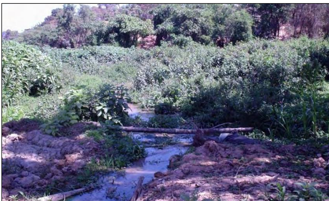
Figura 46 Situação da área antes das obras do programa Drenurbs.
