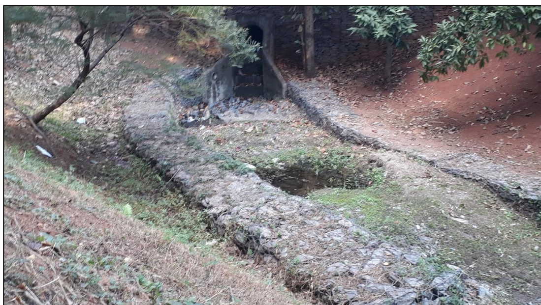
Figura 16 Vista do canal aberto
