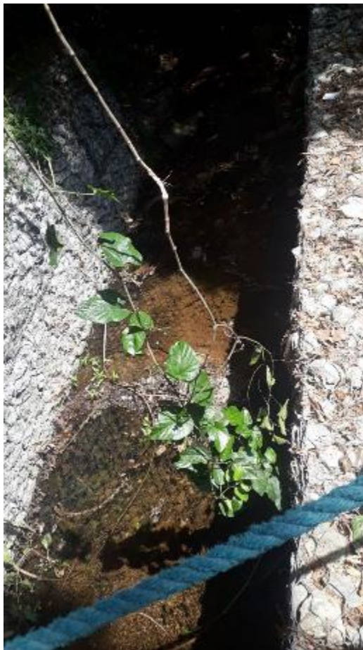
Figura 10 Vista do ponto à montante da bacia de detenção.
