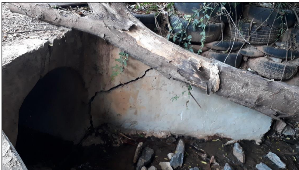
Figura 31 Tubulação chegando ao parque na margem direita da bacia de retenção.
