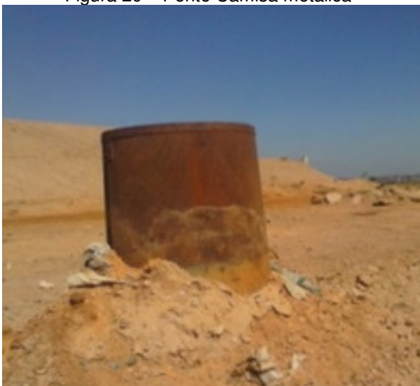
Figura 20 – Ponto Camisa metálica
