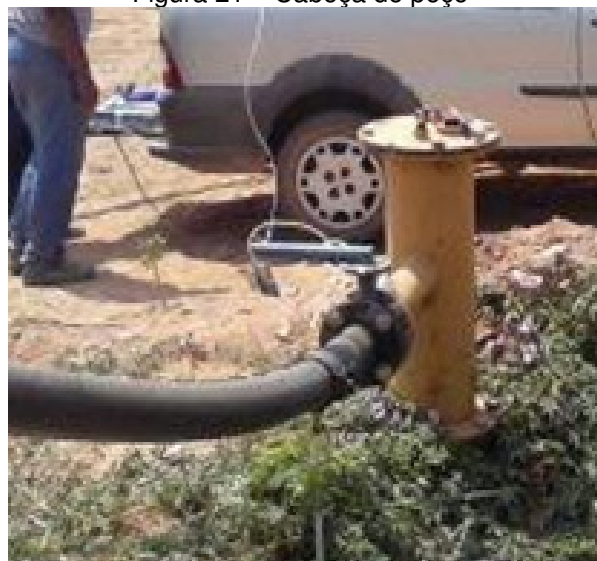
Figura 21 – Cabeça de poço
