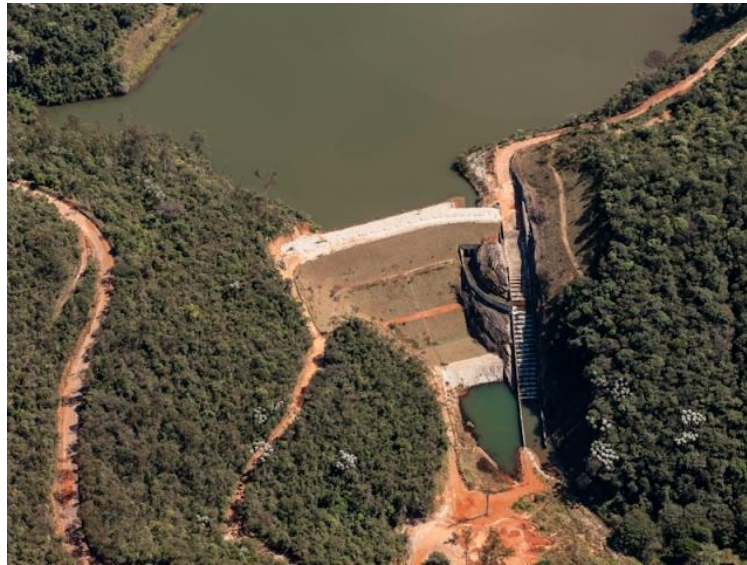
Figura 3 - Barragem do Diogo FONTE: VALE S/A
