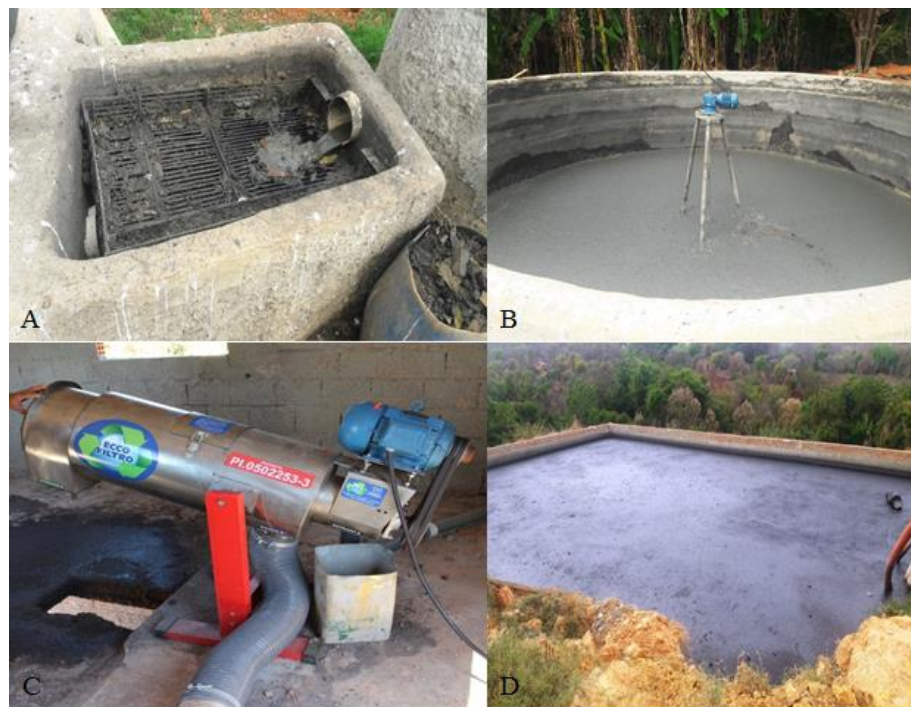
FIGURA 18 – Unidades do sistema de tratamento de efluentes: (A) Gradeamento (B) Tanque de equalização (C) “Ecco Filtro” (D) Tanque temporário
