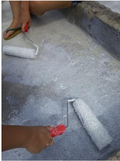
Figura 33 - Aplicação do impermeabilizante
