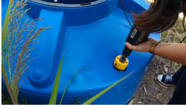
Figura 46 - Furos para a chegada da calha
