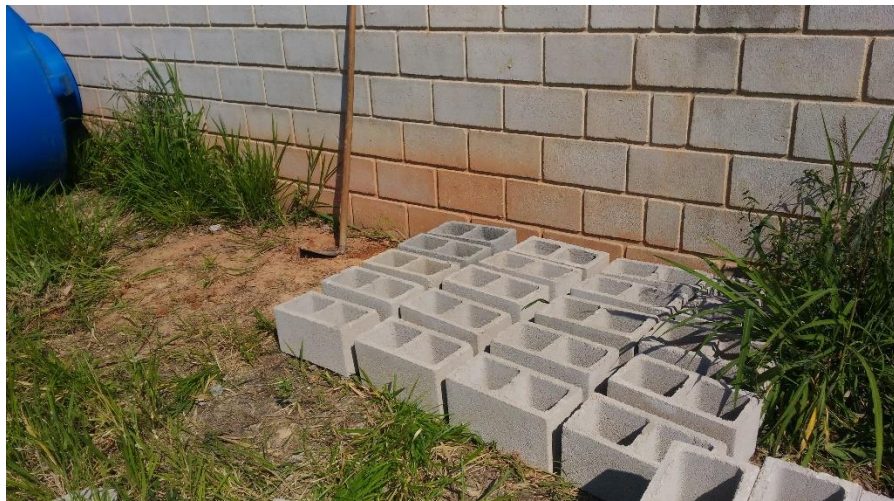
Figura 45 - Nivelamento do reservatório
