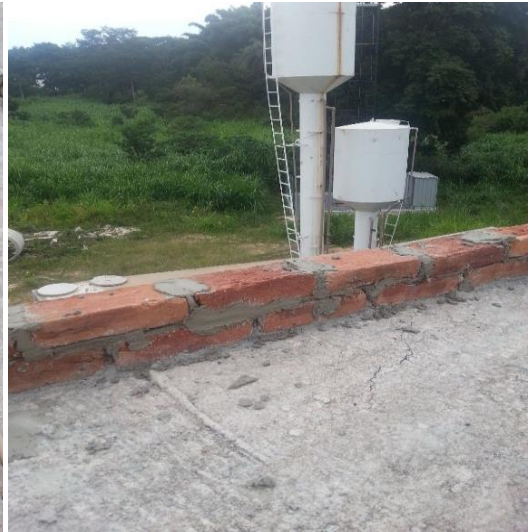
Figura 25 – Platibanda executada
