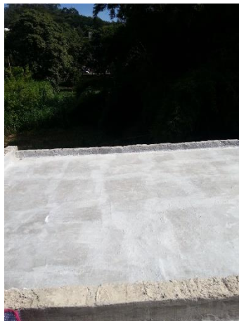
Figura 34 - Laje com duas demãos de impermeabilizante
