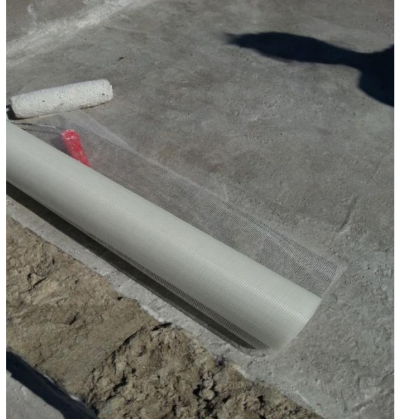
Figura 36 – Colocação da Tela
