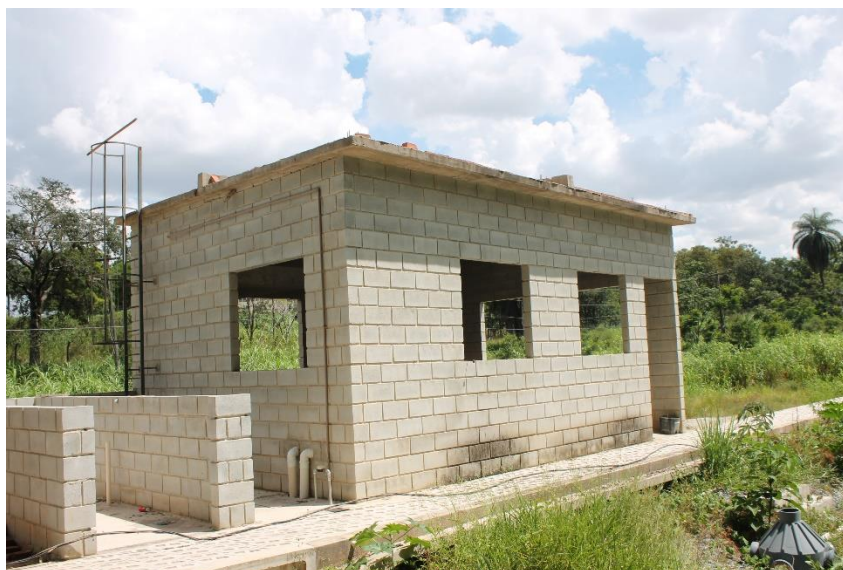
Figura 23 – Edificação existente, campus da UFMG
