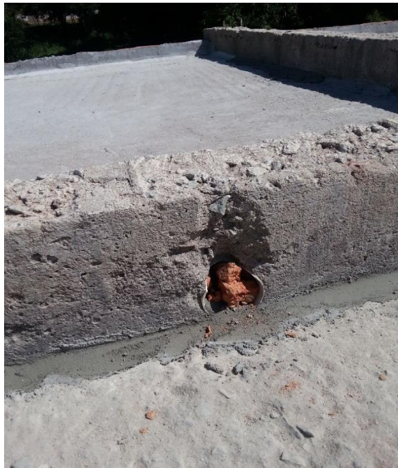
Figura 27 - Fechamento dos buracos nas vigas
