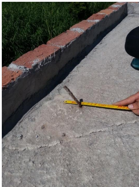
Figura 26 - Retirada dos ferros da estrutura
