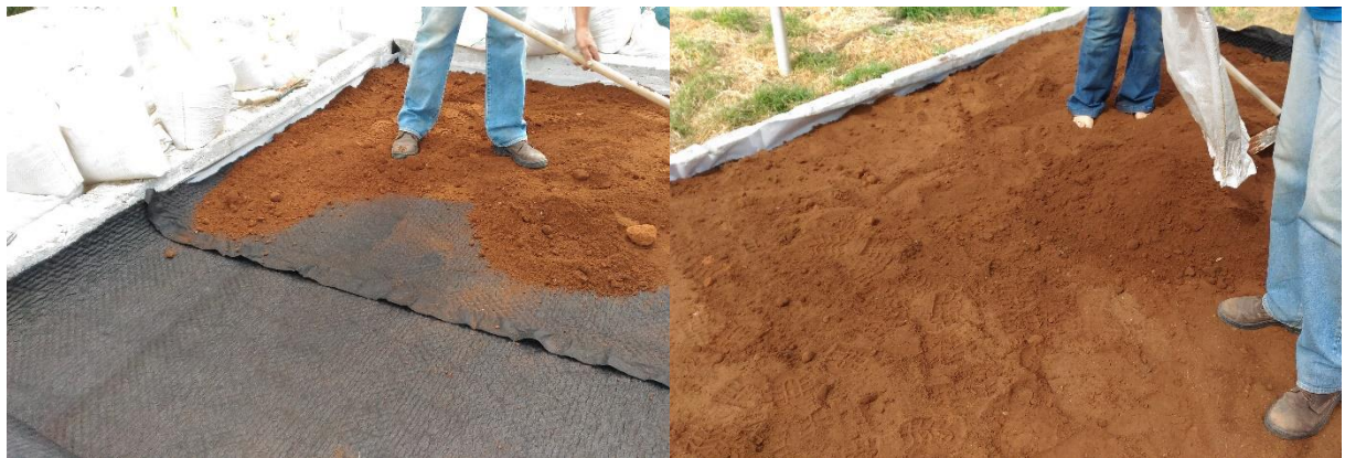
Figura 41 - Colocação da terra vegetal nos compartimentos
