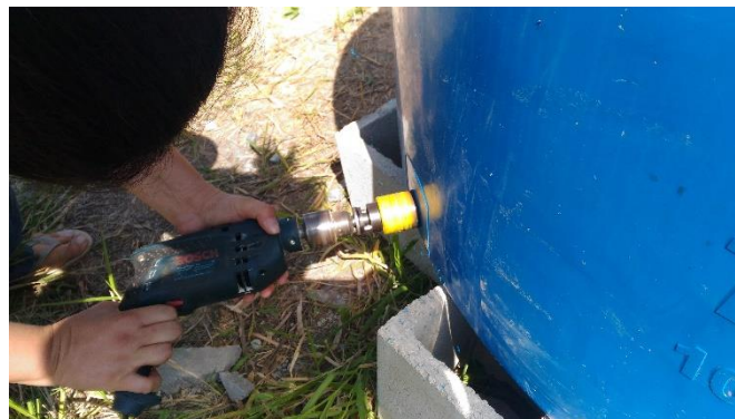
Figura 51 - Instalação do registro
