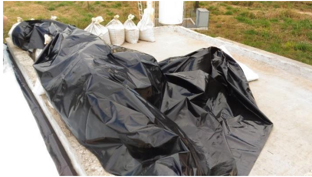
Figura 37 - Lona colocada antes da camada de drenagem
