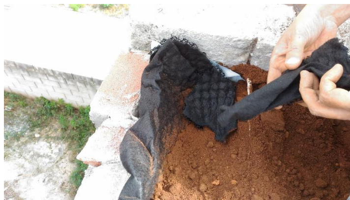
Figura 40 - Reforço nos tubos de descida
