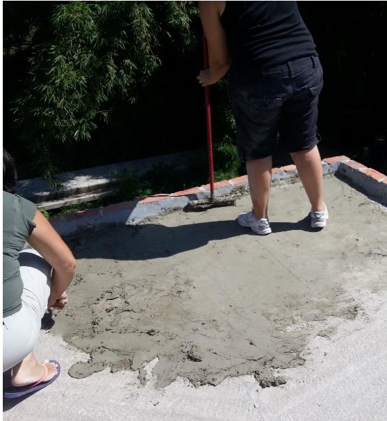
Figura 29 - Aplicação da nata com rodo
