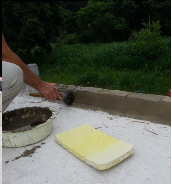
Figura 30 - Aplicação da nata na platibanda
