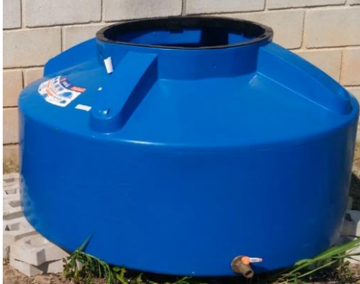
Figura 49 - Registro instalado no fundo da caixa
