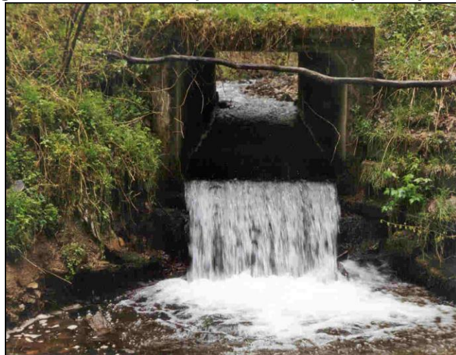
Figura 1 - Bueiro intransponível devido à queda a jusante
