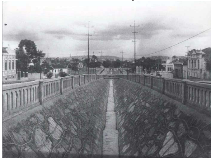
Figura 17 - Córrego do Acaba Mundo canalizado em trecho próximo a Igreja de Nossa Senhora da Boa Viajem.
