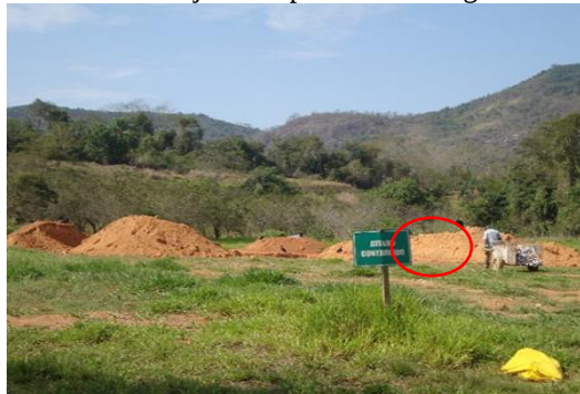
Figura 17 - Área da vala de rejeitos, com placa de aterro controlado; funcionário levando carrinho com rejeitos separados na triagem.
