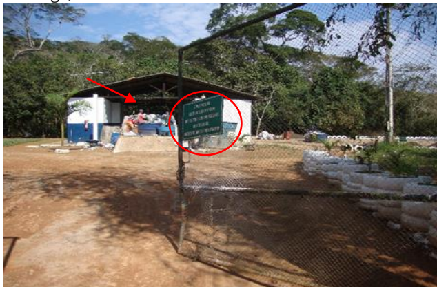
Figura 12 - Vista frontal da UTC; placa de alerta no portão de acesso; funcionários realizando a triagem na área de descarga, ao fundo.
