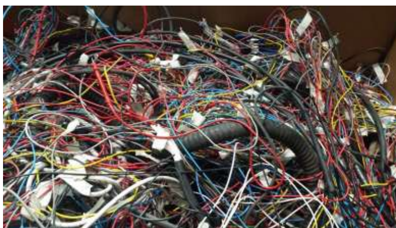
Figura 8 – Cabos elétricos segregados, acondicionados e armazenados na MS Geradores
