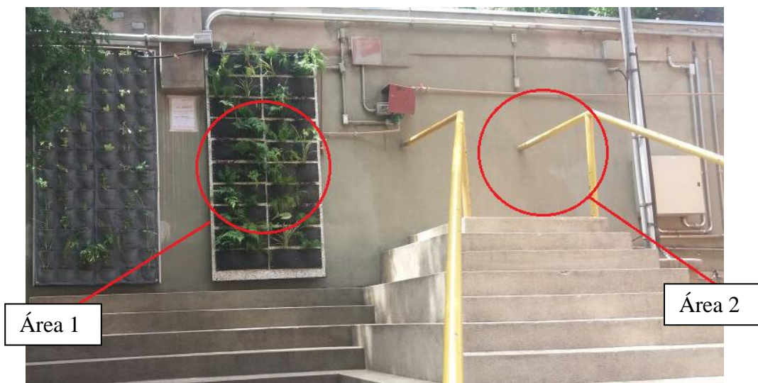
Figura 14: Locais onde foram aferidas a temperatura e umidade do ar
