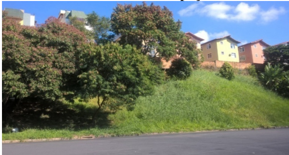
Figura 17 - Talude com altura variável que delimitam a área interna na lateral direita da indústria de autopeças
