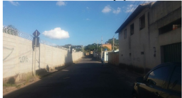
Figura 18 – Muros de alvenaria (à esquerda na foto) que delimitam a área interna da indústria de autopeças
